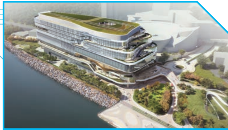
The Cyberport Expansion Project (Cyberport 5) progressed steadily in 2023/24. 數碼港擴建計劃(數碼港第五期)於2023/24年度穩步推進。
